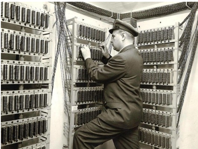
Pannello cablaggi per centrale telefonica, 1968
