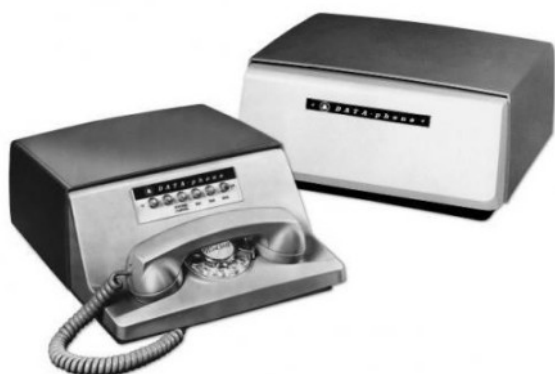
Bell 101, il primo modem commerciale
