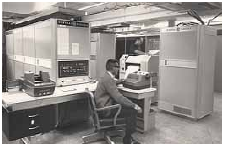
Computer General Electric 225, sul quale venne realizzato al Dartmouth College il sistema operativo DTSS Immagine: IEEE
